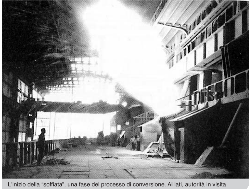
L'inizio della "soffiata", una fase del processo di conversione. Ai lati, autorità in visita
